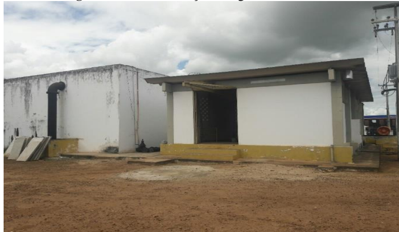
Figura 3.1. 9 - Reservação de água tratada na ETA
